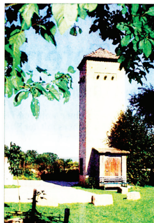
Wird demnächst umgerüstet: Das Trafohäuschen in Wetzendorf.
