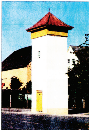
Schmucker Turm: Das erneuerte Trafohäuschen in Städten.
